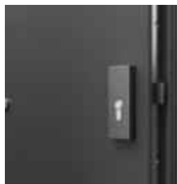
zamek listwowy dostosowany pod dwie wkładki patentowe
