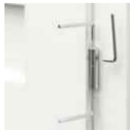
regulacja zawiasów czopowych regulowanych 3D
